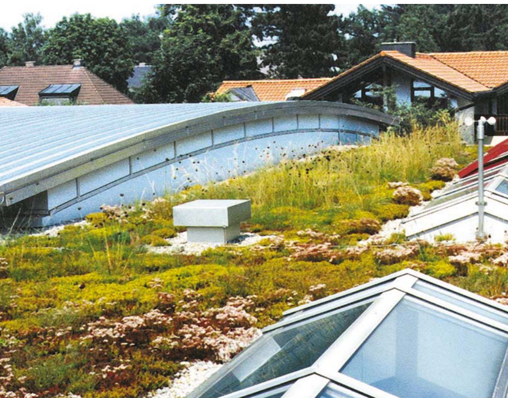
01-02| Příklady skladby jednoplášové vegetační střešy s parozábranou, tepelnou izolací a hydroizolací z asfaltových pásů
